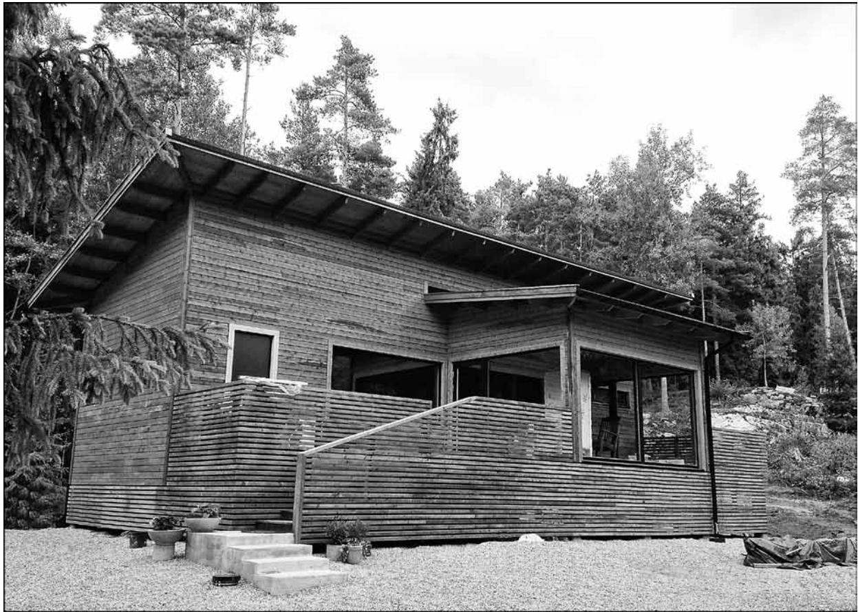
Talossa on tehty sähkötyöt suojatuilla putkituksilla ja seinissä on matkapuhelinmastoilta suojaavaa verkkoa. Kenttävoimakkuudet sisällä ovat hyvin alhaiset.
